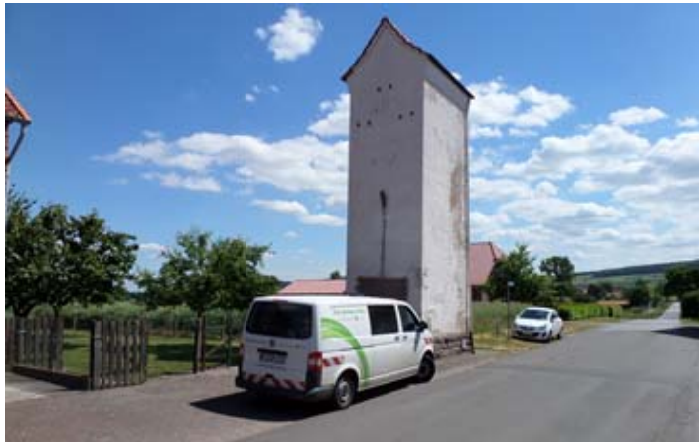
Ehemalige Trafostation in Eilensen 2)
