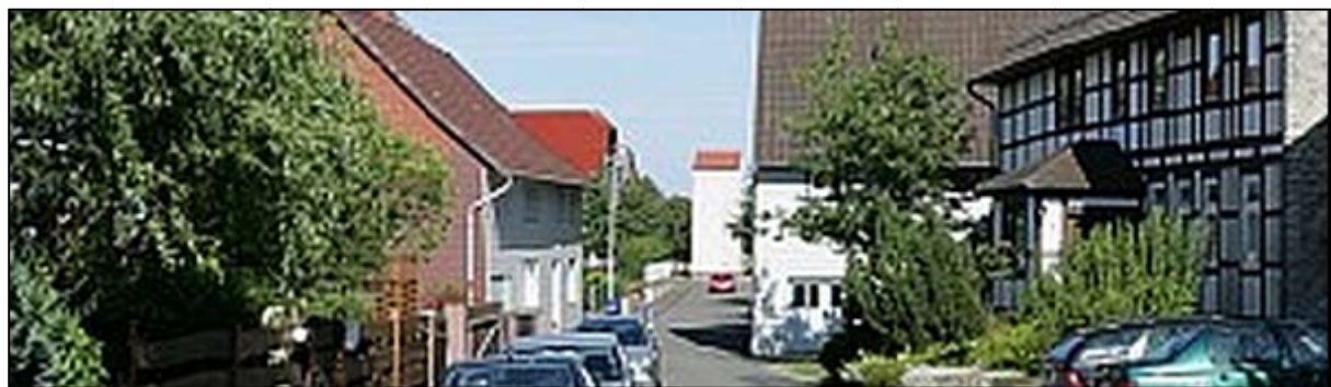
Blick in die Eilenser Straße – im Hintergrund in der Bildmitte das ehemalige Trafohaus 2)
