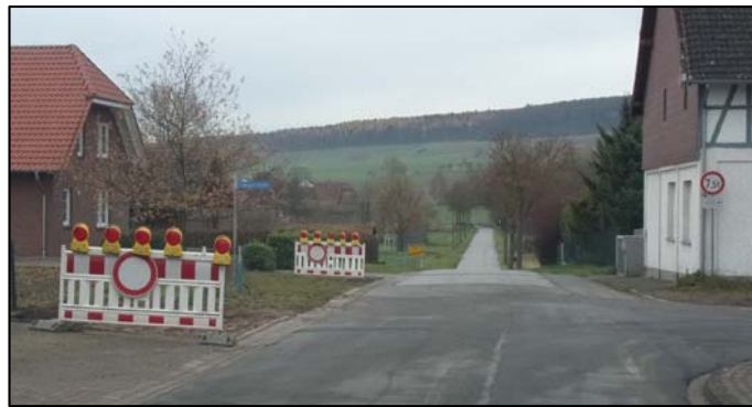
▼ Foto nach Abriss des Gebäudes 2)
