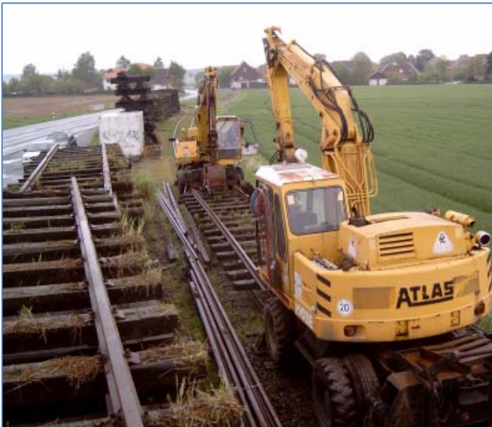
Rückbauarbeiten an der ehemaligen Rübenverladestation Eilensen
